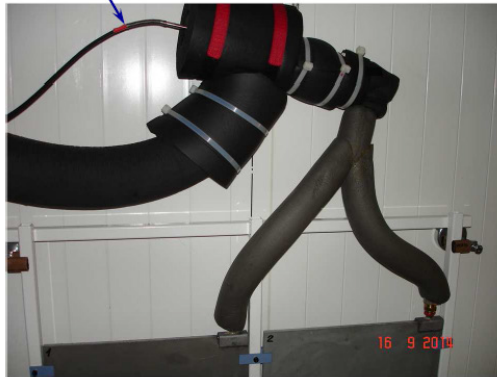
Abbildung 103: Wärmedämmung der Rohrleitungen (links) und Ersatzanschluss aus Stahl (rechts)
